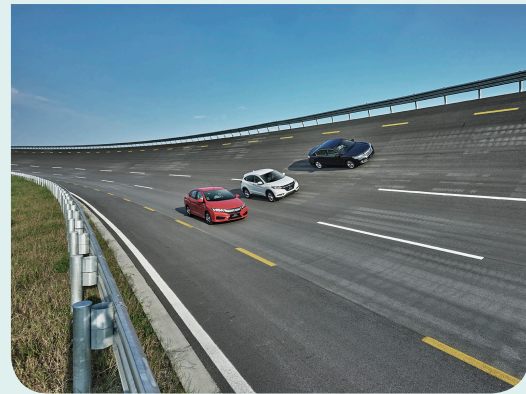
• 高速环道试车场： 全长 4.2km、最高设计时速 180km/h。
