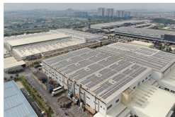
供应商的光伏建设项目
